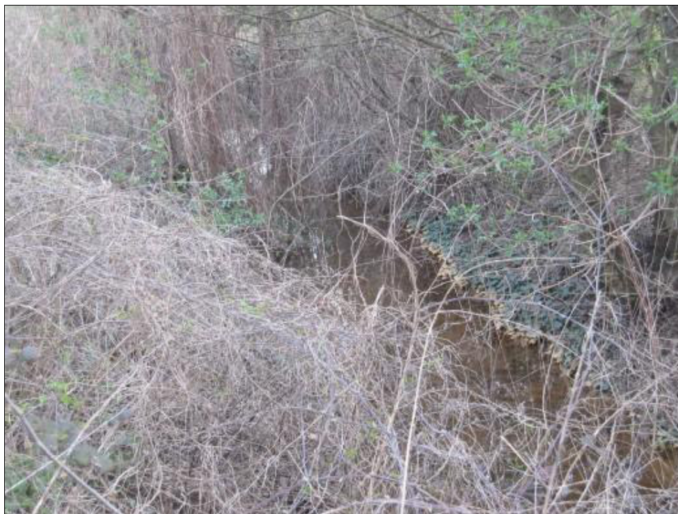
Fig. 4 Particolare dei canali di scolo.
