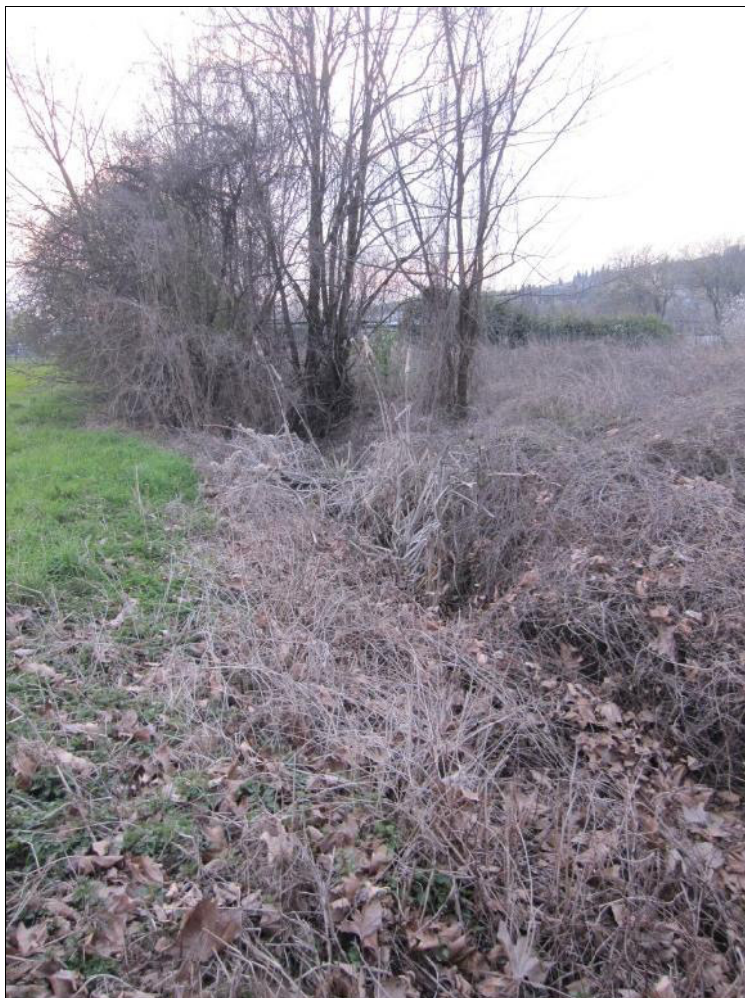
Fig. 6 Particolare dei canali di scolo.
